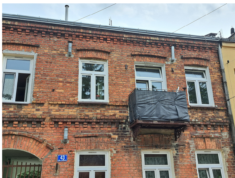
Zdjęcie nr 8: Widok elewacji frontowej, strona prawa, okna piętra
