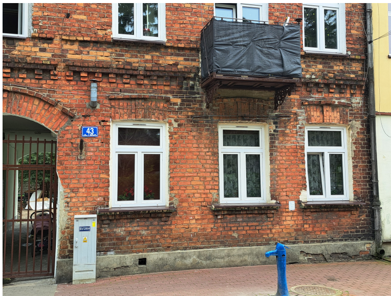
Zdjęcie nr 9: Widok elewacji frontowej, strona prawa, okna parteru
