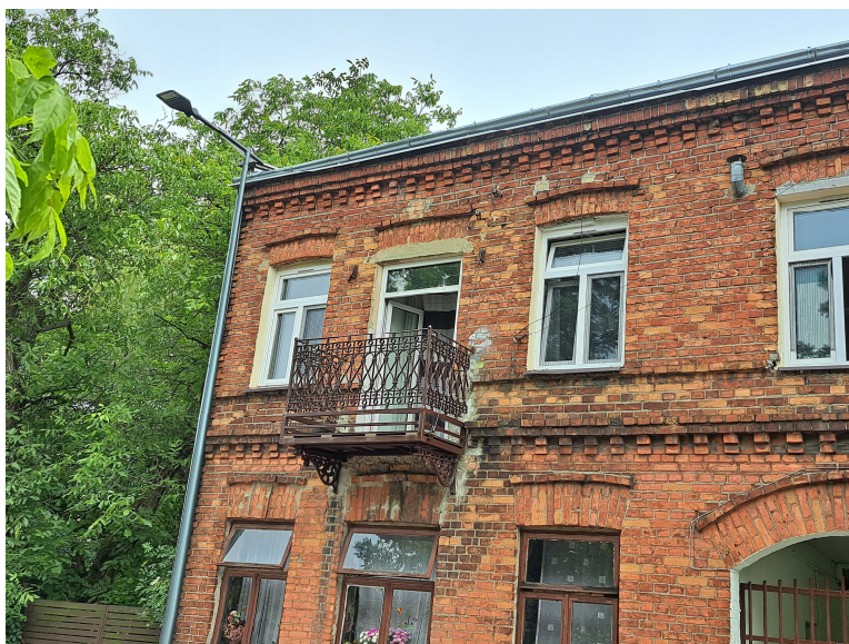
Zdjęcie nr 10: Widok elewacji frontowej, strona lewa, okna piętra
