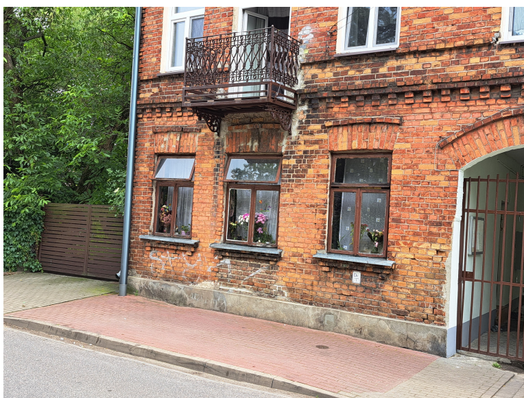
Zdjęcie nr 11: Widok elewacji frontowej, strona lewa, okna parteru
