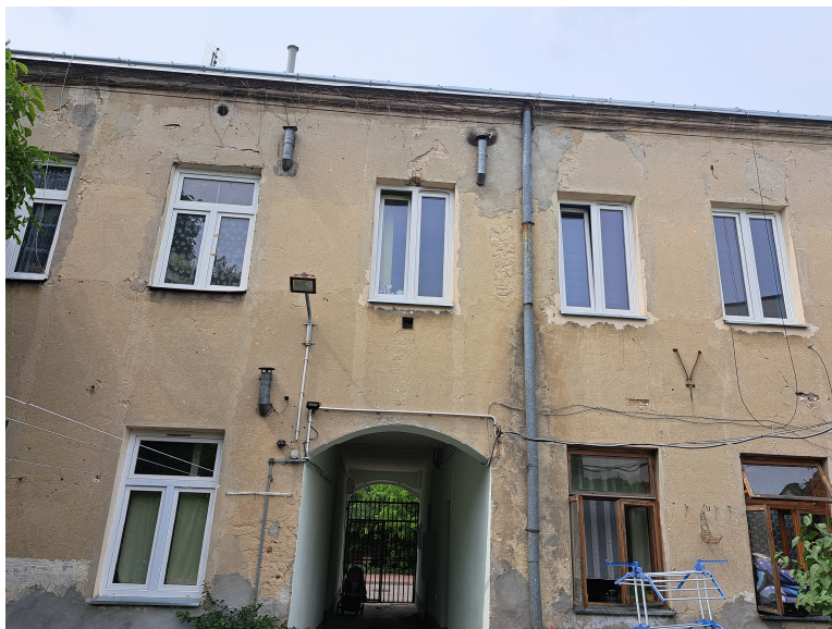
Zdjęcie nr 1: Widok elewacji tylnej, część centralna
