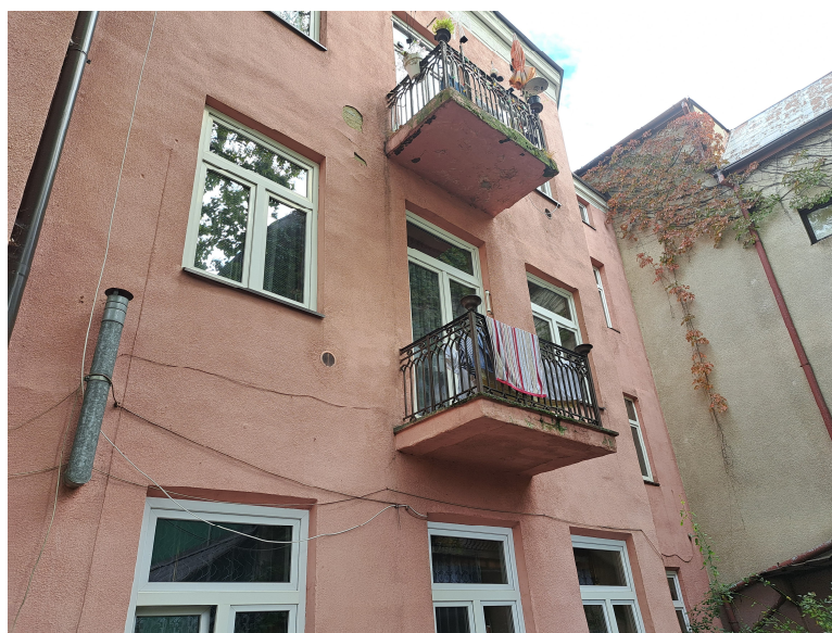
Zdjęcie nr 1: Widok elewacji frontowej, strona prawa, widoczne balkony z płytą pełną typu Kleina
