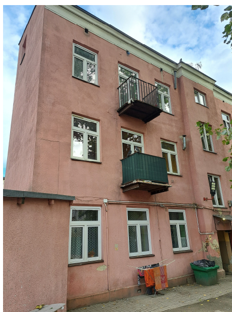
Zdjęcie nr 4: Widok elewacji frontowej, strona lewa, widoczne balkony z płytą z desek drewnianych
